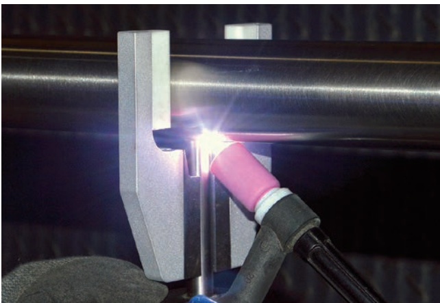
Setzen der Schweißpunkte
