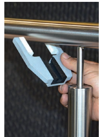
Abführen der Vorrichtung und Fertigstellen der Schweißarbeiten
